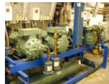
Figur 6.7. Kølekompressorer – en skrue til venstre med en stempel ved siden af.
